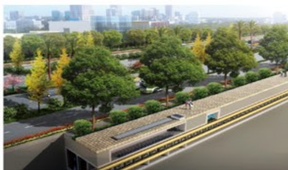
项目名称: 台州市地下综合管廊一期工程市区段 服务类型: 第三方安全巡检 项目概况: 总建筑面积15万平方米, 总投资额为17亿元
