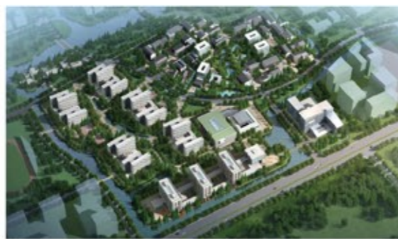
项目名称: 杭州师范大学仓前校区 服务类型: 驻场安全咨询 项目概况: 总建筑面积约为15万平方米, 总投资约为5亿元
