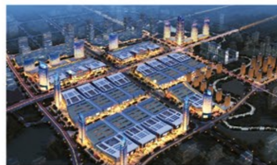
项目名称: 遵义国际商贸城 服务类型: 第三方安全巡检 项目规模: 总建筑面积约为160万平方米, 总投资约为60亿元
