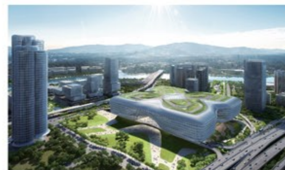
项目名称: 皇岗口岸重建工程 服务类型: 第三方安全巡检 项目概况: 总建筑面积约为40万平方米, 总投资约为50亿元
