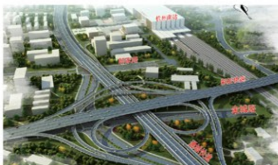
项目名称: 通城大道快速路 服务类型: 第三方安全巡检 项目概况: 工程主线高架桥梁段总长2042m, 总投资额为9亿元
