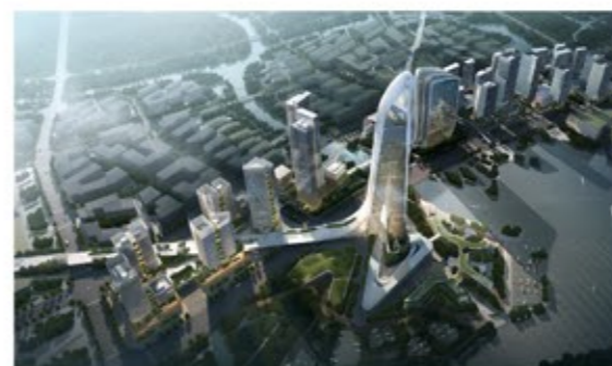
项目名称: 湖州南太湖CBD 服务类型: 第三方安全巡检 项目概况: 总建筑面积约77万平方米, 总投资额约为40亿元
