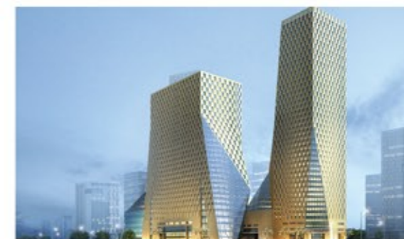
项目名称: 中国人寿大厦 服务类型: 第三方安全巡检 项目概况: 总建筑面积约为42万平方米, 总投资额为59亿元
