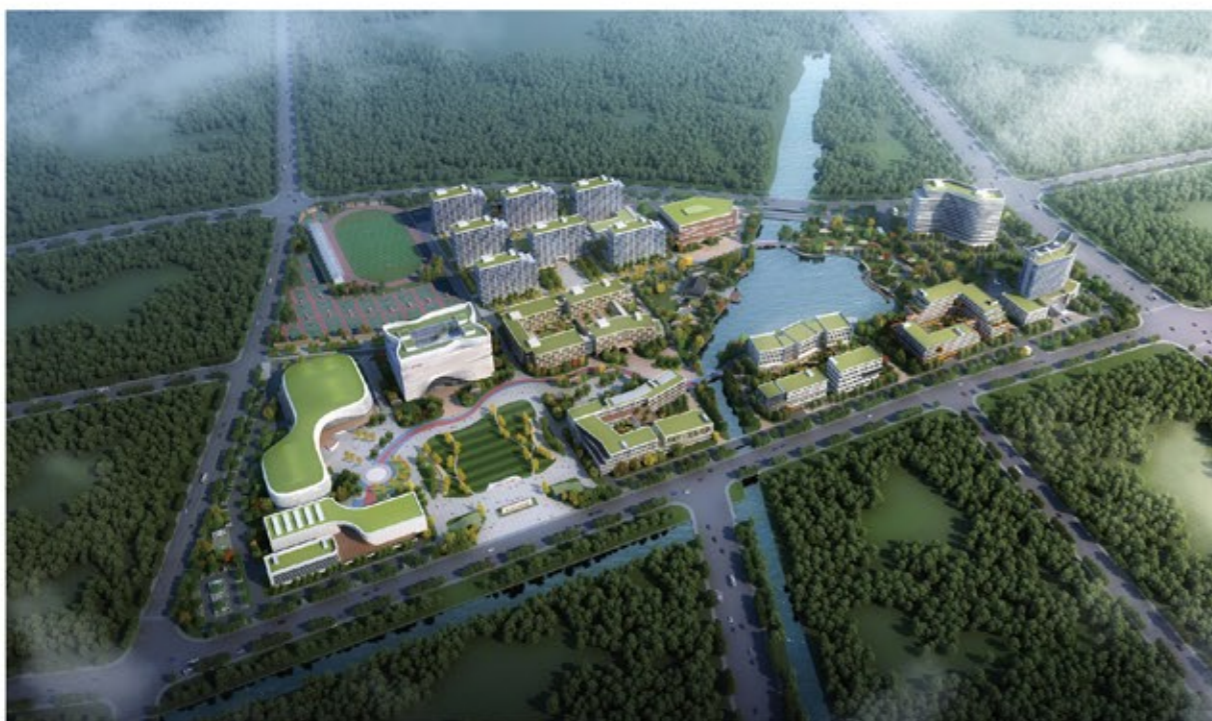
项目名称: 浙江理工大学时尚学院 服务类型: 驻场安全咨询 项目概况: 总建筑面积约为30万平方米, 总投资约为30亿元
