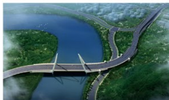
项目名称: 临海市伏龙大桥 服务类型: 第三方安全巡检 项目概况: 工程全长1910m, 总投资约为6亿元
