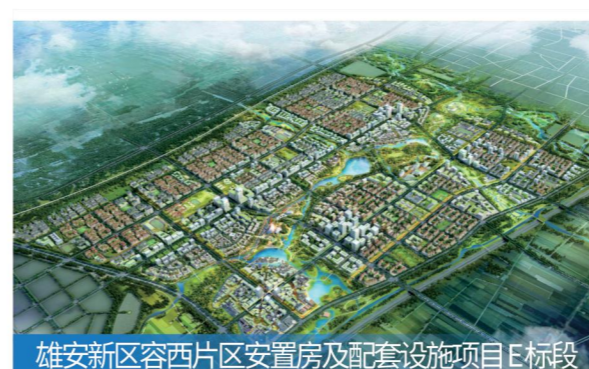
雄安新区容西片区安置房及配套设施项目E标段
