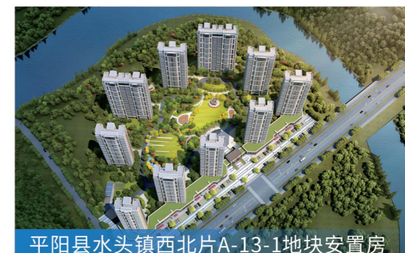
平阳县水头镇西北片A-13-1地块安置房
