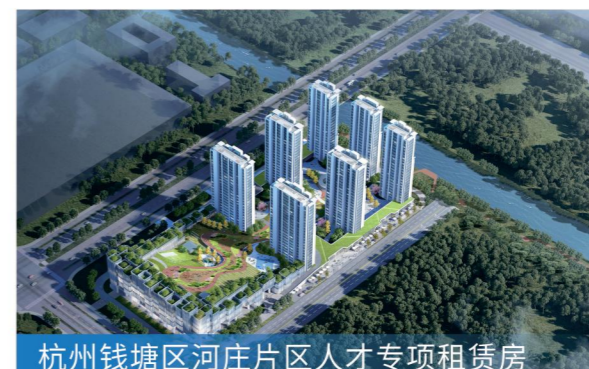
杭州钱塘区河庄片区人才专项租赁房
