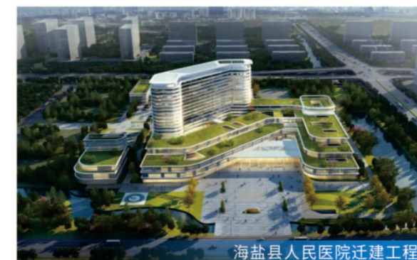
海盐县人民医院迁建工程
